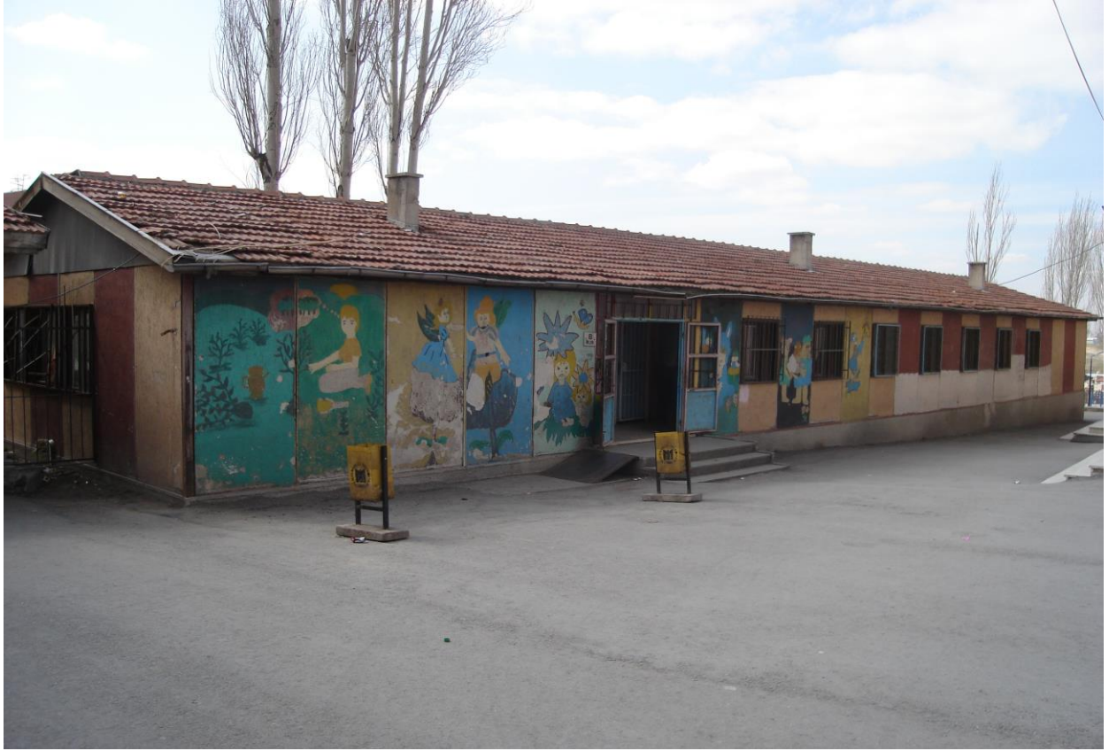
PİREFABRİK BİNA(1985 YILINDA HİZMETE AÇILMIŞTIR)
