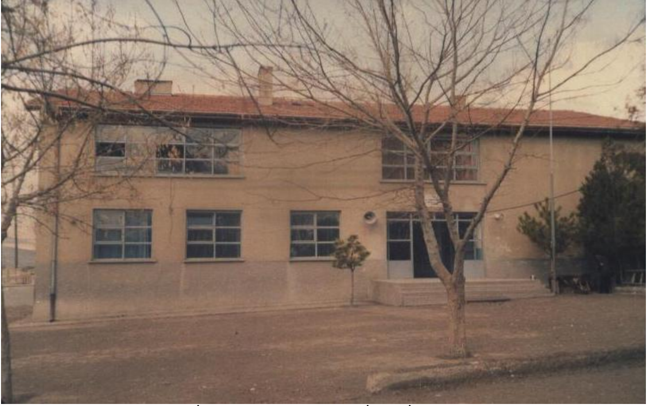
(B) BLOK(1977 YILINDA HİZMETE AÇILMIŞ) ESKİ HALİ
