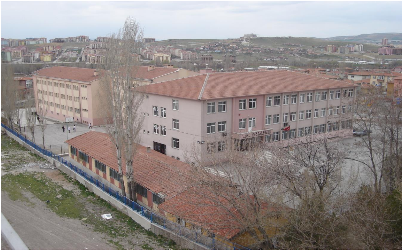
(A) BLOK ANA BİNA VE PİREFABRİK BİNA
