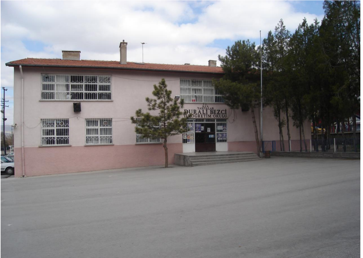
(B) BLOK(1977 YILINDA HİZMETE AÇILMIŞ) TADİLAT GÖRMÜŞ HALİ
